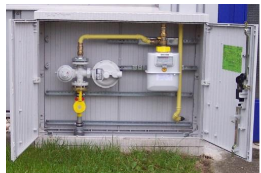
Bild 3: Gasanschluss-Übergabestation
