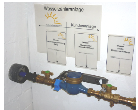
Bild 3: Wasserzähleranlage bis QN 10 (Q3 16)
